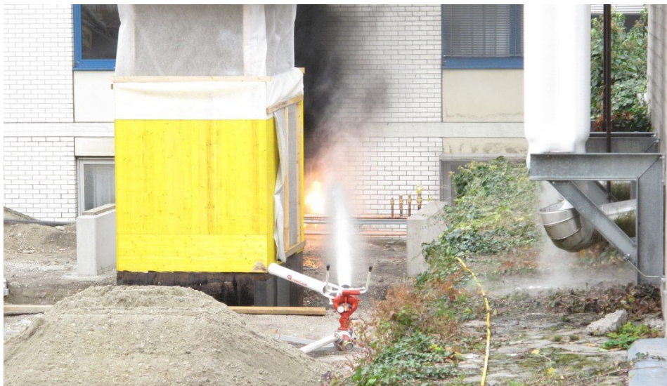
Abbildung 23: Kühlen der Rückwand bei Acetylenflaschenbrand (Presseteam FF Wr. Neustadt)
